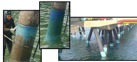
Recubrimiento de protección de estructuras semi-sumergidas y sumergidas de pilotes de pantalán.
